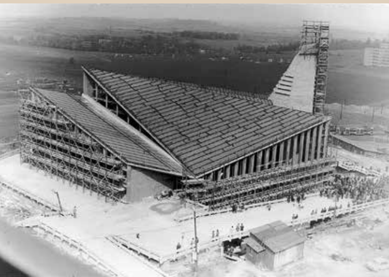
Budowa kościoła w Mistrzejowicach, 1978 r.
