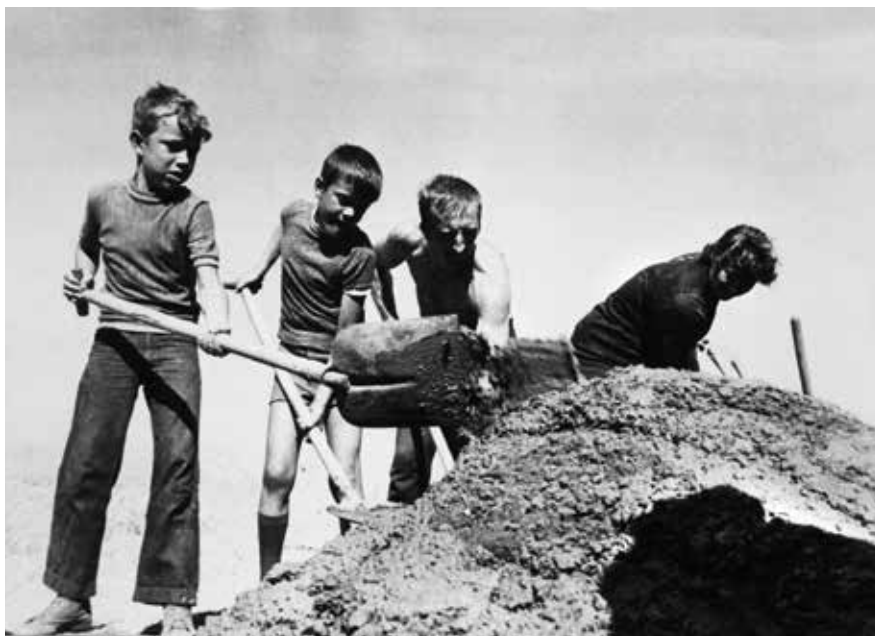
Wolontariusze w trakcie budowy, Mistrzejowice
