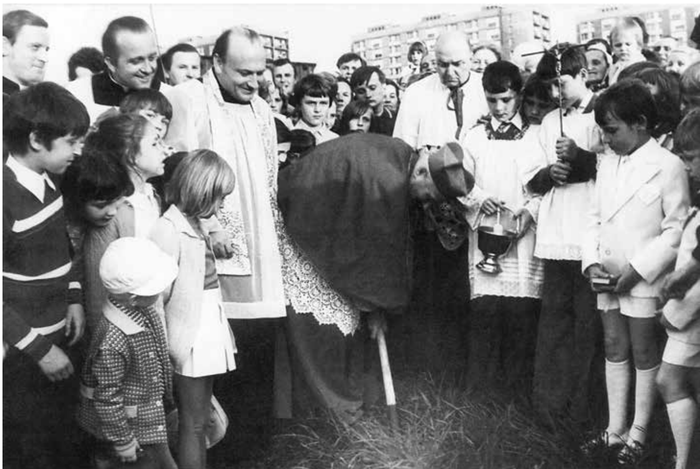
14 maja 1975 r. Arcybiskup Metropolita Krakowski kardynał Karol Wojtyła poświęcił plac budowy i wykopał symbolicznie „pierwszą łopatę” na terenie przyszłej budowy kościoła w Mistrzejowicach
