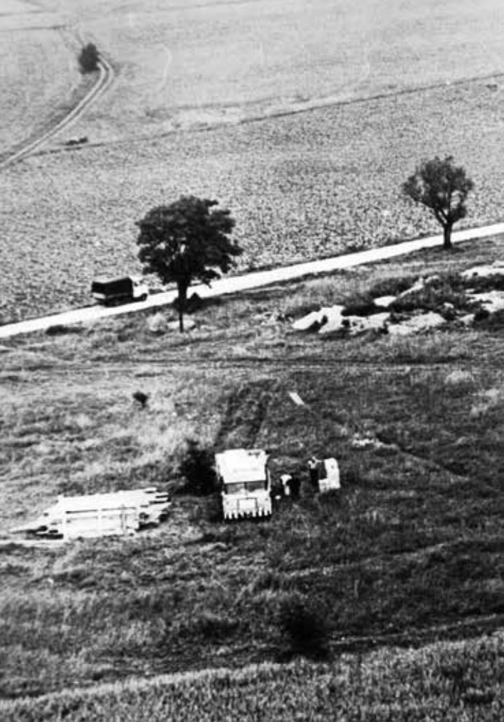
Teren pod budowę kościoła w Mistrzejowicach
