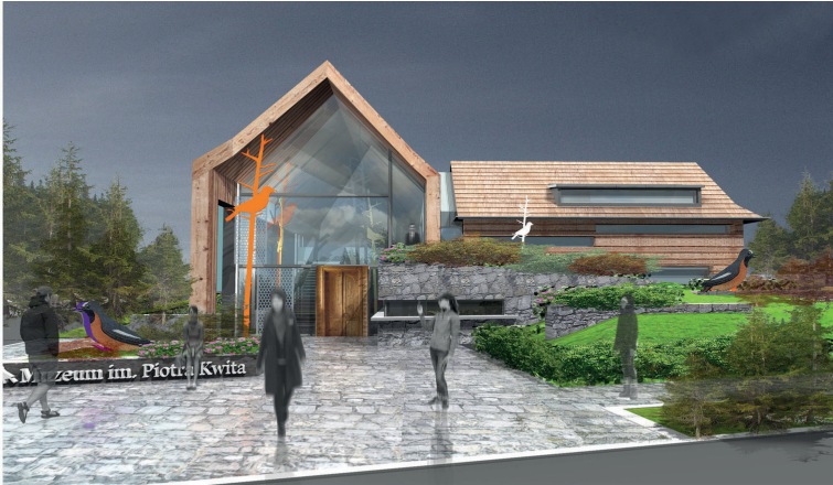
widok od strony południowej
